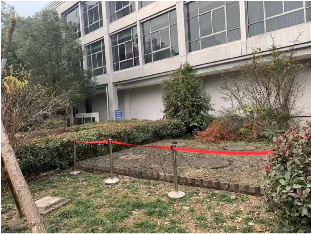
衰变池及防护措施
