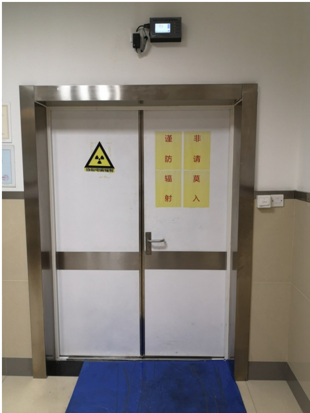
入口防护门上电离辐射警示标识及中文警示说明
